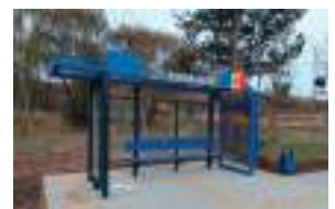
Fig. 14. Stație de așteptare a transportului public amenajată cu plăci tactile
