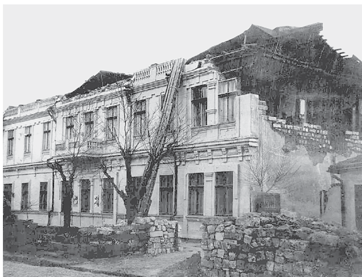
Fig. 1.19. Clădire din orașul Chișinău avariata de seismul din 10 noiembrie 1940
