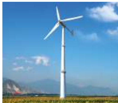
Fig. 5. Turbină eoliană axială rapidă
