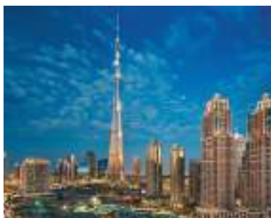
Fig. 10. Clădirea Burj-Khalifa, 828 m, 2009 (Dubai, Emiratele Arabe Unite)
