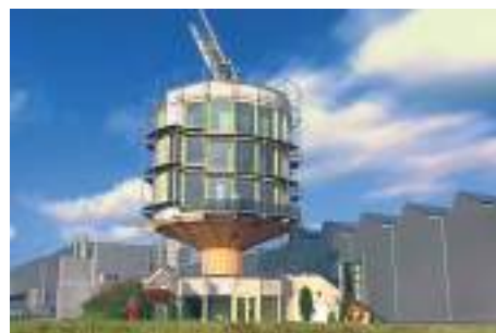
Fig. 12. Casă care se rotește după soare (Freiburg, Germania)
