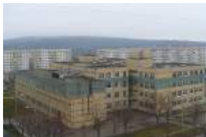
Fig. 5. Clădirea Liceului Dacia , municipiul Chișinău
