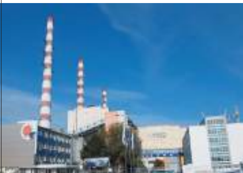
Fig. 3.46. Centrala Termoelectrică Moldovenească de la Dnestrovsc
