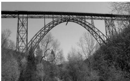
Мост в городе Müngsten или «Мост Императора Вильгельма» является самым высоким железнодорожным мостом в Германии. Он построен на реке Wupper недалеко от города Müngsten. Мост представляет собой железную конструкцию, имеющую вес в 5000 тонн, длину в 465 м и высоту в 107 м, а расстояние между столбами в 170 м.
