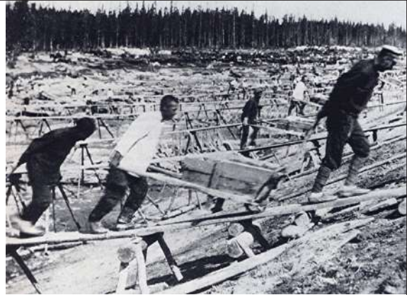
Deținuți din gulag, muncind la construcția Canalului Marea Albă – Marea Baltică (1932)
