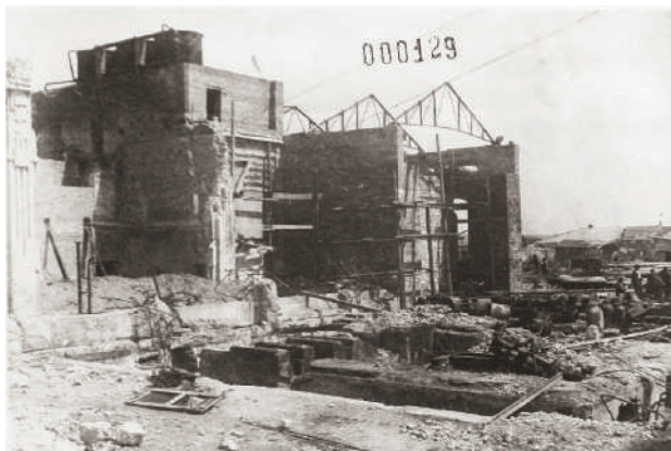
Stația electrică orășenească, 1944-1945. Sursa: ANA, F. 1026, inv. 2, d. 340, f. 1.
